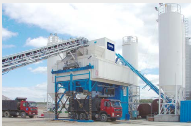
TWINMIX 3,00 im Einsatz bei einem Flughafenbauprojekt
